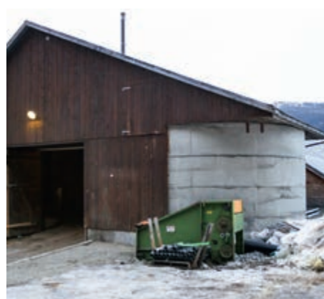
I dag tipper flisa rett i siloen, men på sikt skal den blåses inn gjennom en luke i fjøsveggen.
